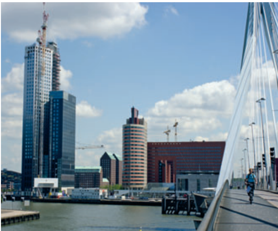
Voor koeling en verwarming van de Maastoren wordt gebruikgemaakt van het Maaswater.
