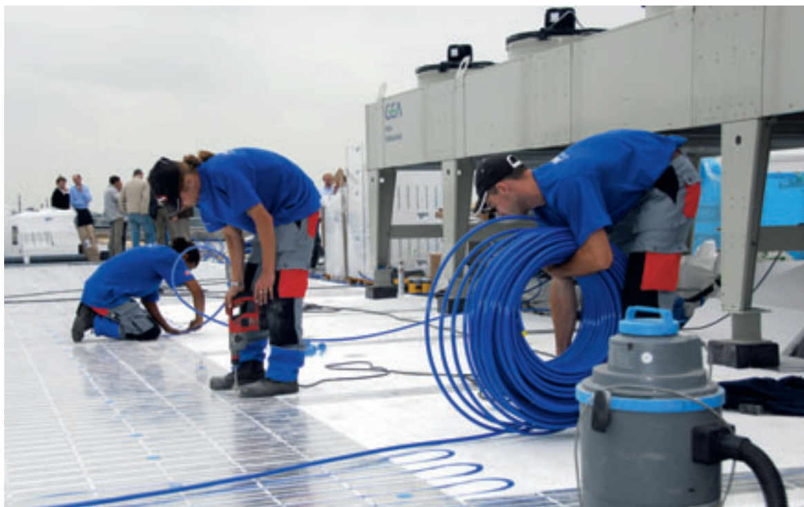
Het leggen van het energiedak op de nieuwbouw van het Koning Willem I College.
