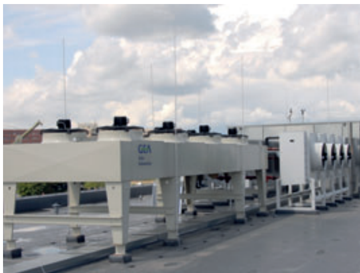
De dakopstelling van de units op gebouw Z, Koning Willem I College.
