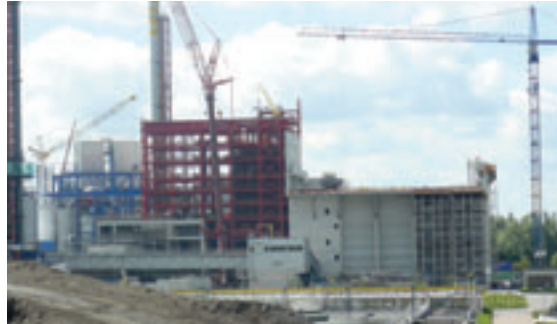
Zijaanzichten van de bouw op het HVC-terrein.
