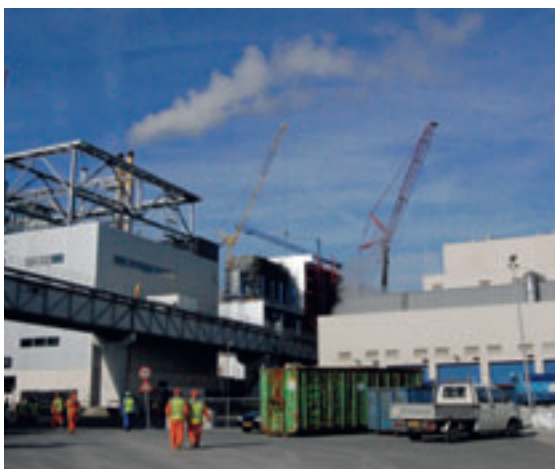
Tijdens de bouw blijven de overige installaties van het afvalnutsbedrijf HVE in bedrijf.
