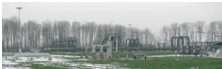
Gaslocatie in het noorden.
