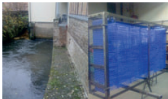
12. Gebruik van warmte-energie uit een rivier bij een gemaal.
