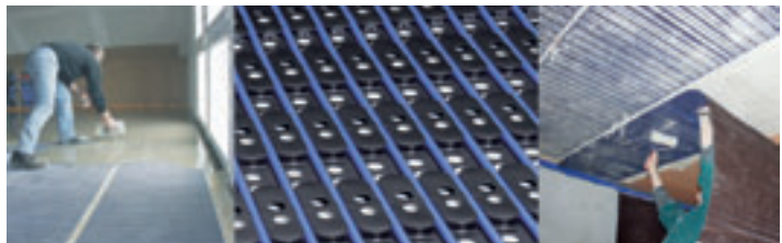
7. Systeem op basis van capillaire buismatten type Folimat voor thermisch te activeren vloeren, wanden en plafonds.
